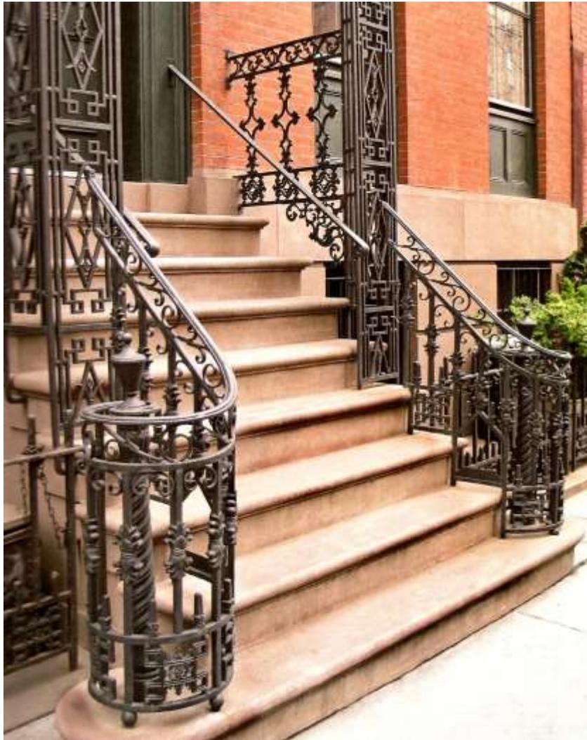
**Rampes et grilles en fer forgé devant l'entrée d'une maison New Yorkaise. Ces modèles composés d'attaches, de torsades, de figures géométriques et végétales, illustrent la grande variété du travail en fer forgé. Photo de C. Richards, Design du fer forgé.**
