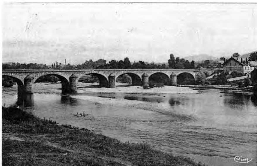
Le pont de Pont-du-Château.
