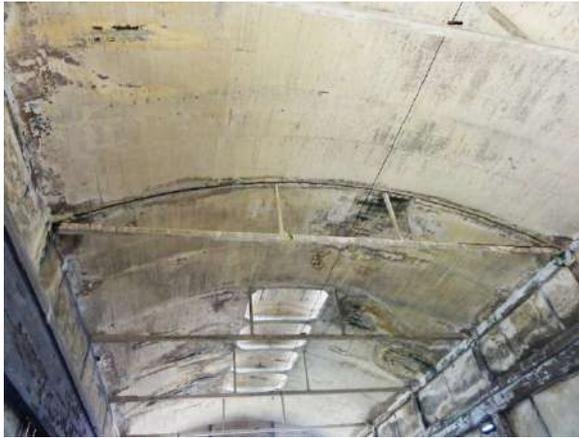
Ferme en béton armé avec deux poinçons
