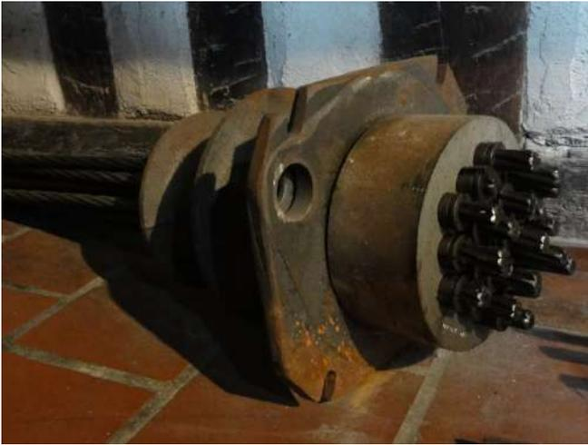
Cône d'ancrage des câbles de précontrainte
