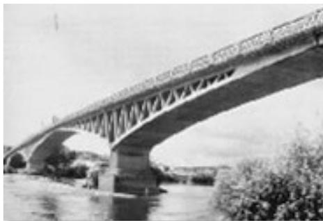
Une fois achevé le pont du Veudre, FREYSSINET et F. MERCIER construisirent le pont Boutiron. Le principe de construction de ce pont était analogue au précédent si ce n'est que les arcs avaient une flèche un peu plus importante. Au moment du coulage du pont, une crue emporta une partie des cintres. FREYSSINET dirigea alors le renforcement des cintres et coula le reste du pont sans discontinuer pendant 3 jours et 2 nuits. Le pont était sauvé.
