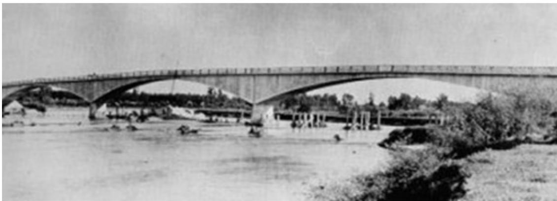
Ce pont, le dernier de la série, était conçu selon les mêmes principes que les précédents (3 travées à arc à trois articulations). Cependant les membrures ont été remplacées par des voiles pleins en béton. Comme pour tous les grands ouvrages d'art le décoffrage est un réel problème car le béton adhère assez fortement aux planches du coffrage et il n'est pas rare que celui-ci soit irrécupérable après décintrement.
